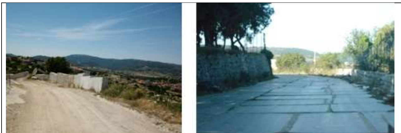
Figura 7: esempi di riutilizzo degli scarti dell'estrazione del granito. Nell'immagine a sinistra, essi sono stati utilizzati come barriere, in quella a destra come pavimentazione stradale
