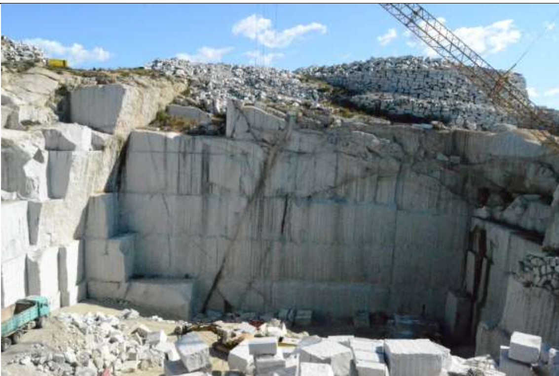
Figura 6: Foto della cava S'Istria sos arestes. I materiali di scarto, nella parte superiore, continuano ad accumularsi creando, tra l'altro, problemi di sicurezza in tutta l'area della cava.
